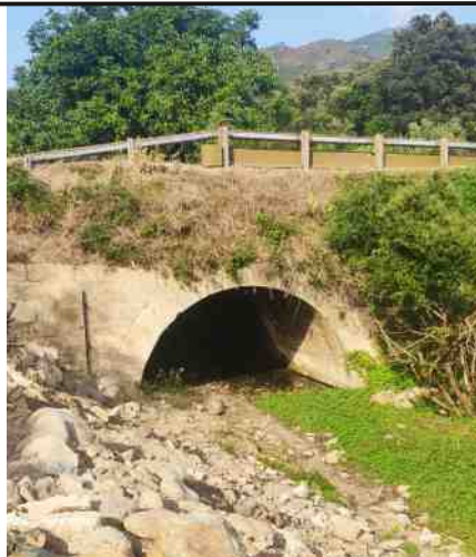
Le pont Napoléon III, à proximité de la cave Orenga.
